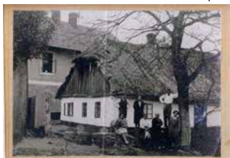
Bývalá potašovna u potoka za domem č. p. 72, Jihlavská
