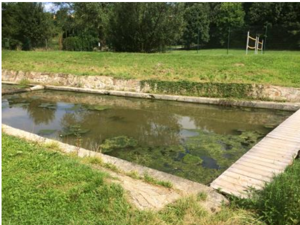
Předčišťovací nádrž a čistící zóna
